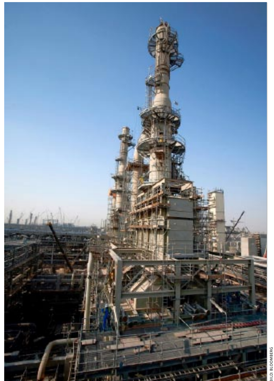
Half Shell 2012 die Produktion zu steigern: Gasverflüssigungsanlage Pearl in Katar.
